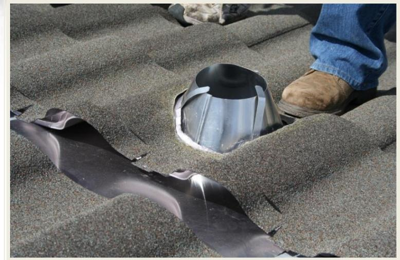
Corte la pieza Villa Underpan (bandeja de desagüe) para que ajuste firmemente. Ajuste de manera que encaje alrededor del caño de salida. Aplique silicón para intemperie por arriba y por los dos lados y termine con el kit de retoque.
