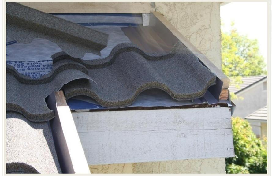
Una hilera corta se inserta cortando la parte de atrás las tejas de la hilera inferior y colocando las tejas enteras encima de las mismas. Las tejas enteras se sujetan por la nariz sobre la parte más alta las tejas de abajo.
