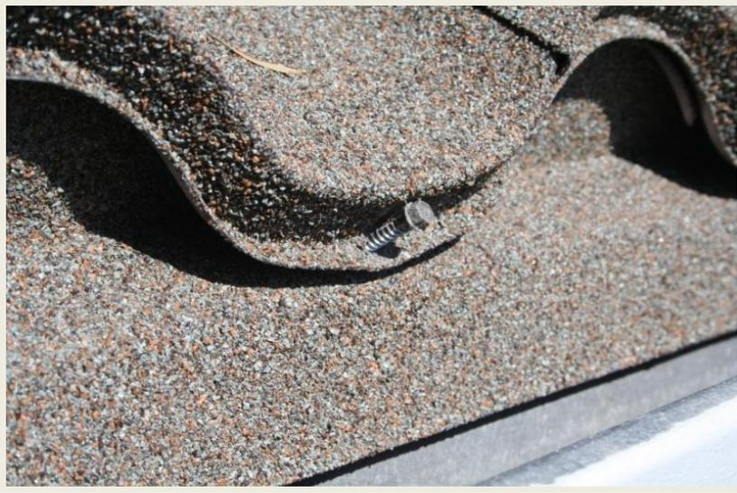
A la vez, fije la teja y la pieza Bird Stop-Eave empleando tornillos anticorrosivos de color de cabeza Hexagonal 1/4" x 1-1/2" largo (0,63 cm x 3,8 cm de largo), los cuales penetrarán por la nariz de la teja, atraviesan la pieza y los sujetan a la cubierta.
