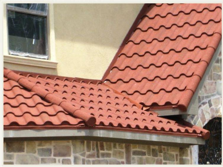
Proceda instalar las tejas por hileras hasta llegar a la pared y corte la parte posterior del último panel de la última hilera para que quede ajustado contra la pared– coloque las piezas Bird Stop – Ridge (remate cumbre).
