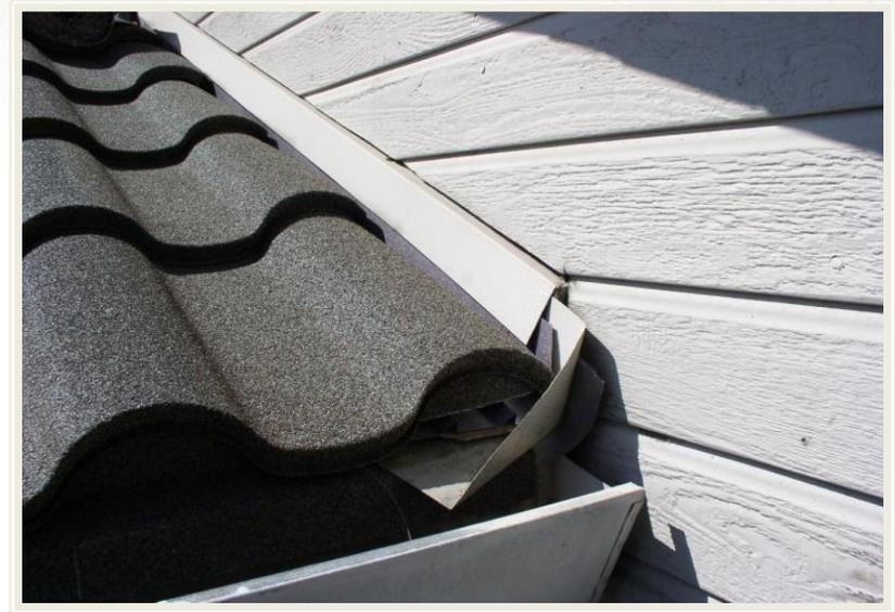
Si se ha empleado un botaguas sobre la pared, pliegue la pieza Villa Channel (canal limatesa) detrás del botaguas existente – corte las tejas y encaje hacia la Villa Channel.
