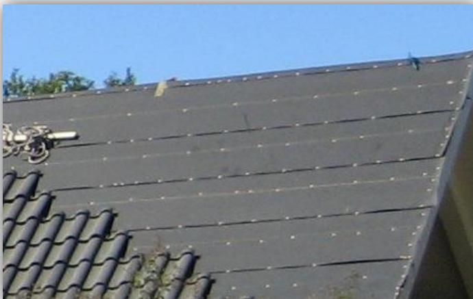
El revestimiento empleado debe cumplir con las especificaciones: ASTM D 226, de Tipo I o Tipo II, ASTM D 4869, Tipo I o II o ASTM D 1970 – o mayor si así lo requieren los códigos de construcción locales vigentes.
